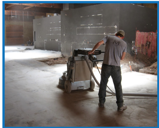
THI CÔNG NỀN SÀN BÊ TÔNG TRẮNG TRÍ
